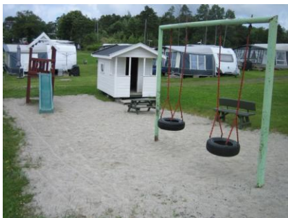
Stativ med sklie er skjevt og ikke tilstrekkelig festet.
